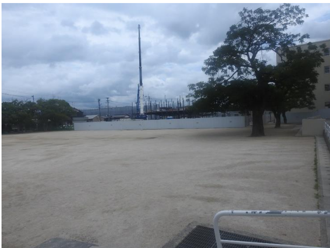
運動場が狭くなっています。安全確保のためフェンスで間仕切っています。
